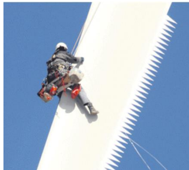
Exemple de peigne acoustique (source : windvision)
